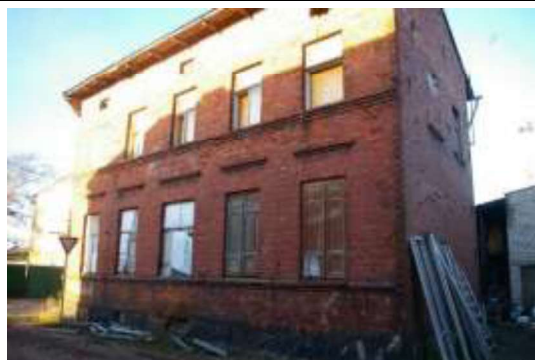
Būve ar kadastra apzīmējumu 1700 020 0161 001, kopskats no Puķu ielas
